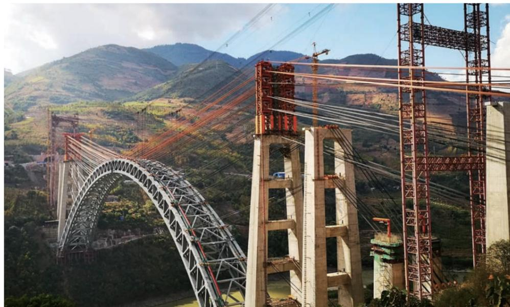
中铁宝桥参建的世界第一跨——中缅国际铁路大瑞怒江特大桥顺利合龙，大桥主跨采用跨度达490米的钢桁拱梁，是目前世界上同类型铁路桥梁的最大跨度
