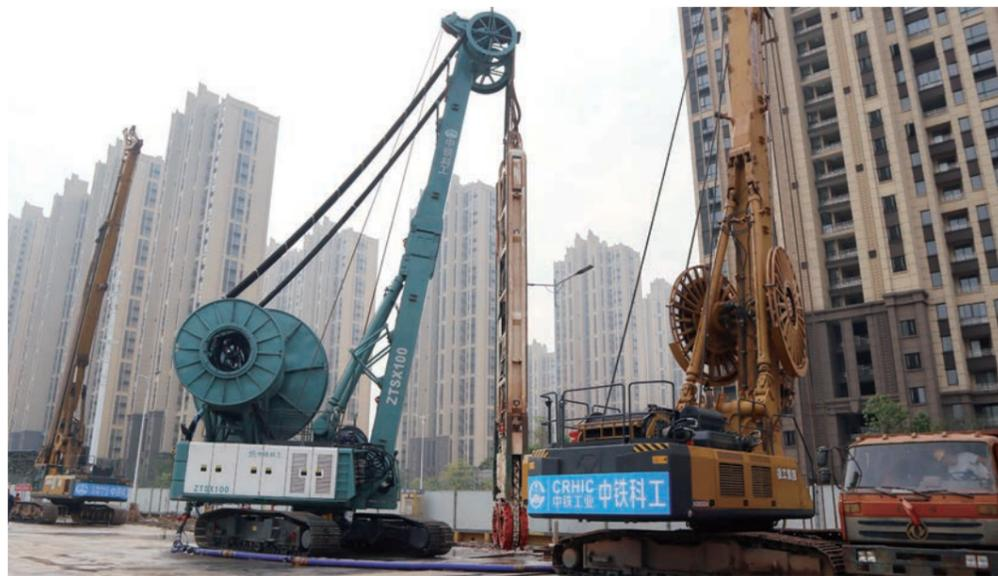
1月30日，首台国产地下连续墙利器——双轮铣装备顺利完成空载调试，助力广州地铁18号线建设，开启我国双轮铣装备研制、工程服务一体化的先河
